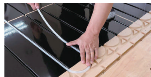
長寿命の樹脂製パイプをつなぎ目なく施工。水漏れの心配が少なく、オリジナルのブラックパネルが遠赤外線効果を高める
