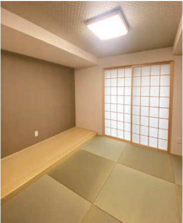
上：床と壁にへム材を使用。調湿効果もあり、 肌触りも良い。小さいスペースだけどこかわりを 下：窓を断熱サッシにし、お家の断熱・気密工事 で住みやすい家に。お施主様からも「早くしてお けばよかった！」と喜びの声をいただいています
