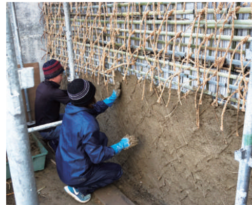
蔵の壁を作る工法を再現。団子状にした土を手で木舞壁(こまいかべ)※につけていく ※竹を縦横に組んだ下地
