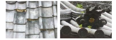
上記の一つでも当てはまっている場合は、もしかしら屋根材に割れやズレ、破損があるかもしれません。屋根は本来、水はけが良く、雨を弾いて水が残らないよう流れ落とす構造になっています。苔が生えるのは水はけが悪くなっている証拠なので、流れを良くする必要があります。また、落ち葉などが溜まっていると、湿気で屋根を傷めたり野地板を腐らせる原因になります。できるだけ小まめに払っておきたいですね。ちなみに、現在の屋根瓦は土を使わないので重量も約半分になっています。メンテナンスすれば100年保ち、飛散や落下を防ぐ設計になっているので、タイミングを見て葺き替えるのもアリです。
